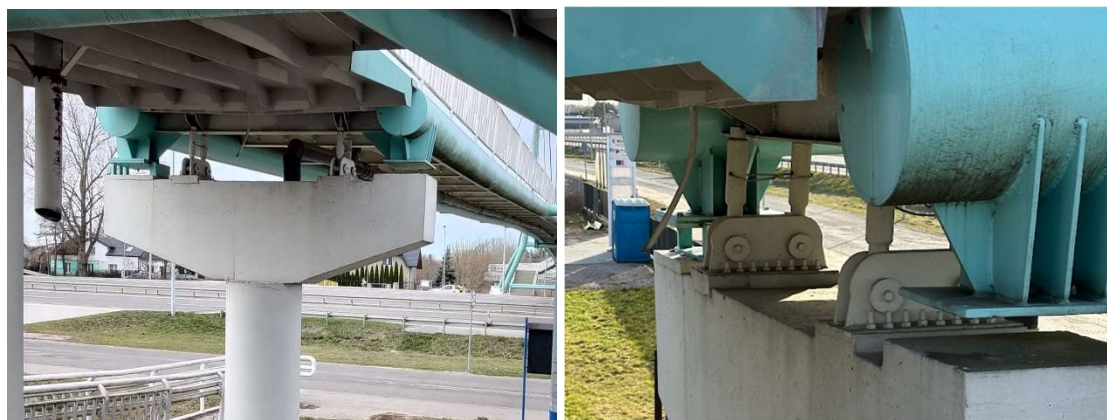
Fot. 12 Widok na łożyska – podpory pośrednie
