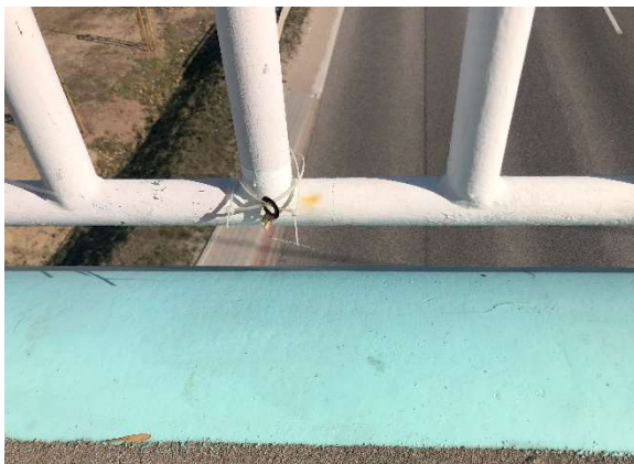
Fot. 46 Miejsce produkty korozji na powierzchni balustrad
