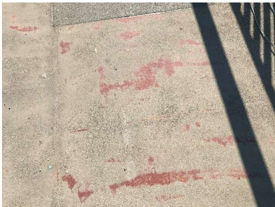
Fot. 41 Ubytki nawierzchnio-izolacji płyty pomostu, lokalne produkty korozji
