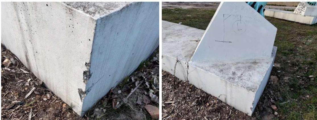
Fot. 33 Zanieczyszczenia betonu ław fundamentowych, wykruszenie betonu w narożniku fundamentu
