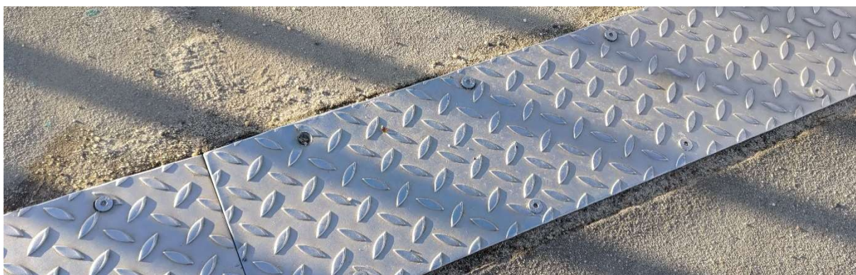
Fot. 15 Widok strefy dylatacyjnej kładki od góry
