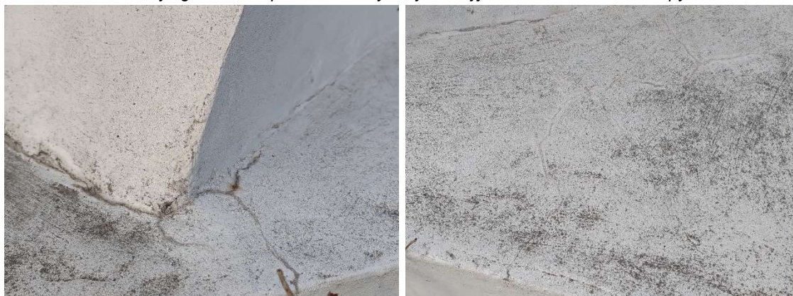
Fot. 31 Zarysowania skurczowe betonu ław fundamentowych
