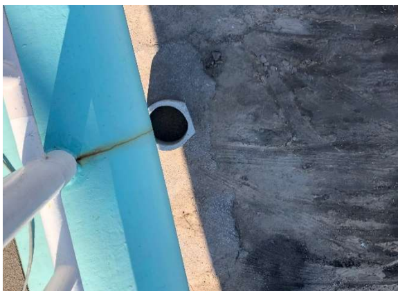
Fot. 48 Rdzawe zacieki z połączeń technologicznych balustrad z dźwigarami głównymi
