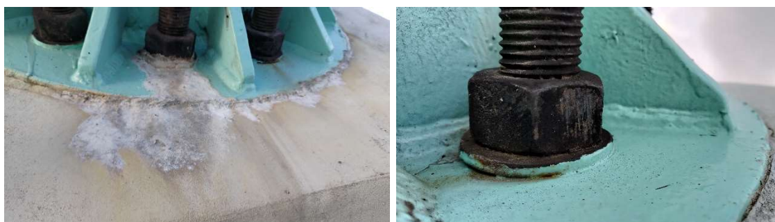
Fot. 30 Wylugowania wapienne oraz wykwyty korozyjne w strefach zakotwień pylonu
