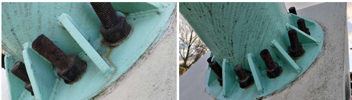
Fot. 29 Produkty korozji w strefach zakotwień pylonu do fundamentu
