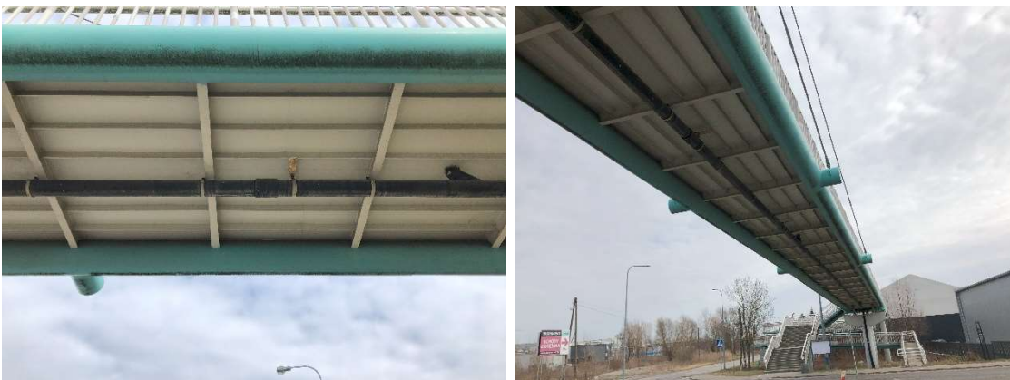
Fot. 23 Korozja płaskowników stalowych – elementów podwieszenia kolektora zbiorczego
