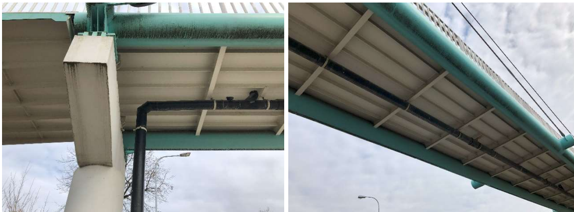
Fot. 20 Widok na kolektor i pion odwodnienia
