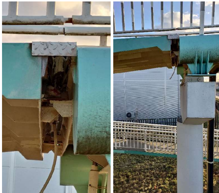
Fot. 17 Niesystemowe odprowadzenie skroplin ze stref dylatacyjnych
