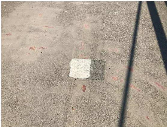
Fot. 39 Ubytki nawierzchnio-izolacji płyty pomostu, lokalne produkty korozji
