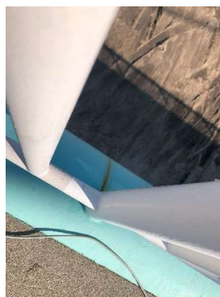
Fot. 48 Rdzawe zacieki z połączeń technologicznych balustrad z dźwigarami głównymi
