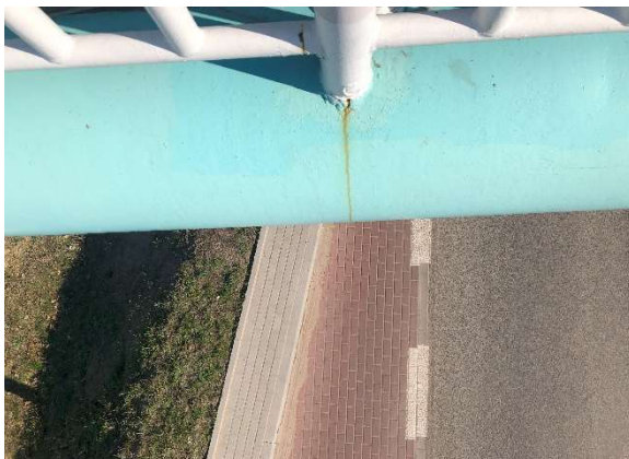
Fot. 47 Rdzawe zacieki z połączeń technologicznych balustrad z dźwigarami głównymi
