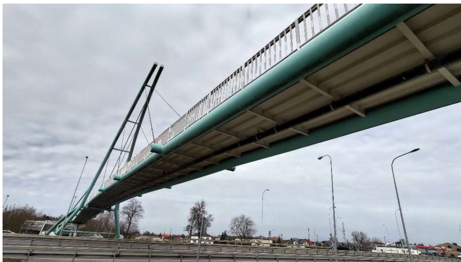
Fot. 24 Zanieczyszczenia oraz zacieki na spodzie dźwigarów głównych
