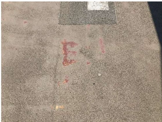
Fot. 40 Uszkodzenia, ubytki nawierzchnio-izolacji obiektu
