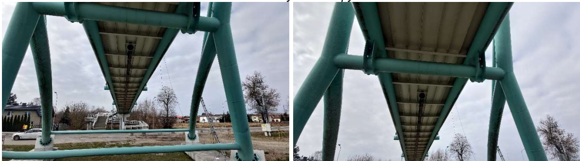
Fot. 28 Widok na spód konstrukcji stalowej pylonu, widoczne zanieczyszczenia
