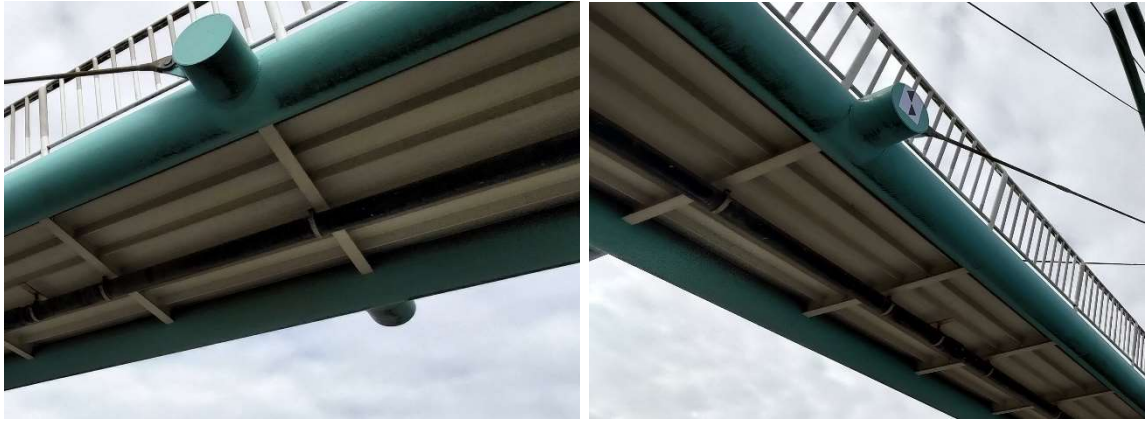
Fot. 26 Widok na spód wsporników pod zakotwieniami want
