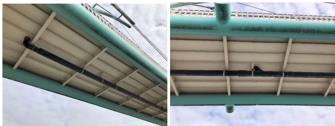
Fot. 22 Korozja płyty pomostu w pobliżu przejść kolektora przez płytę
