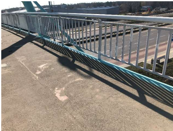
Fot. 45 Widok na balustrady, zanieczyszczenia oraz produkty korozji w strefach dylatacyjnych balustrad
