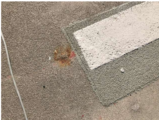
Fot. 41 Ubytki nawierzchnio-izolacji płyty pomostu, lokalne produkty korozji
