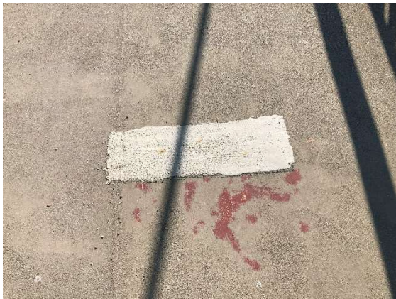
Fot. 39 Ubytki nawierzchnio-izolacji płyty pomostu, lokalne produkty korozji
