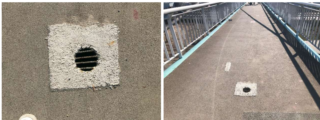
Fot. 36 Widok na nawierzchnię obiektu, produkty korozji w miejscu poprzednich napraw
