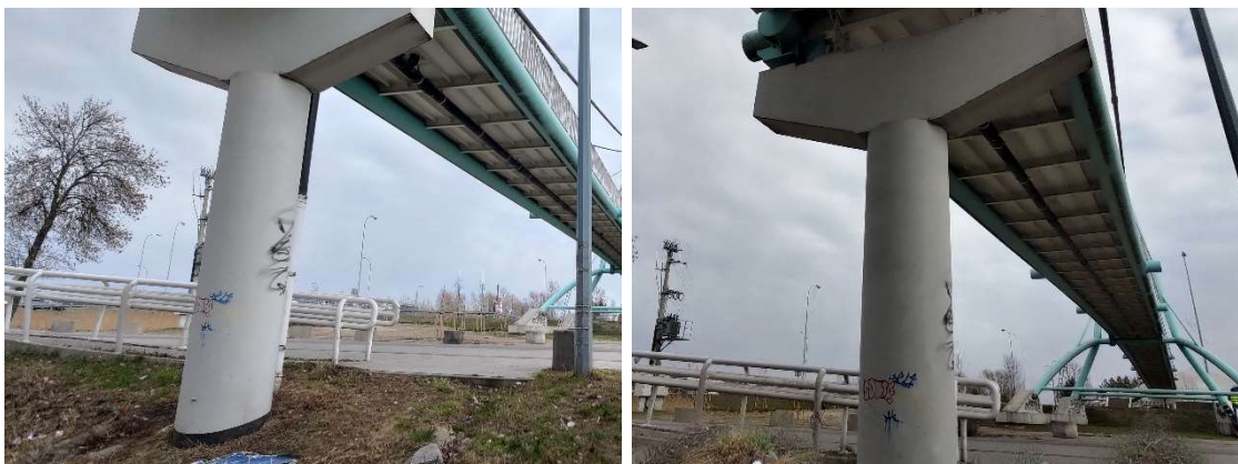
Fot. 35 Zanieczyszczenia podpór
