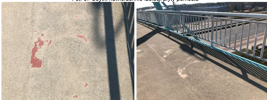
Fot. 38 Uszkodzenia, ubytki nawierzchnio-izolacji obiektu
