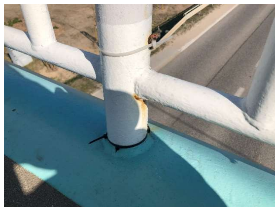
Fot. 46 Miejsce produkty korozji na powierzchni balustrad
