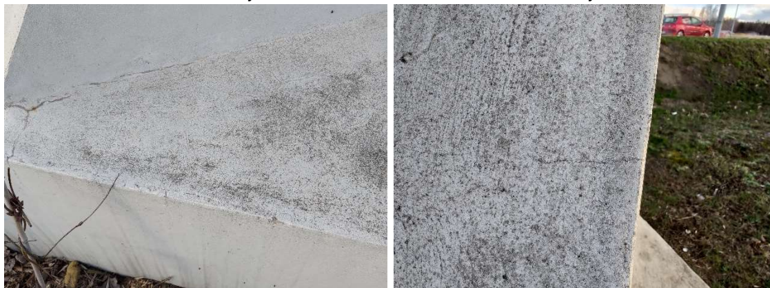
Fot. 32 Zarysowania skurczowe betonu fundamentu
