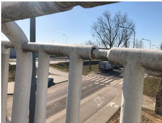
Fot. 45 Widok na balustrady, zanieczyszczenia oraz produkty korozji w strefach dylatacyjnych balustrad
