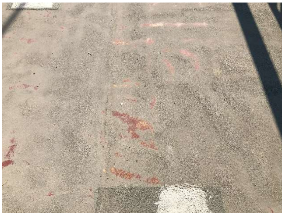
Fot. 40 Uszkodzenia, ubytki nawierzchnio-izolacji obiektu
