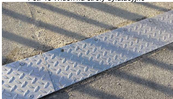
Fot. 44 Widok na blachę przekrycia dylatacyjnego
