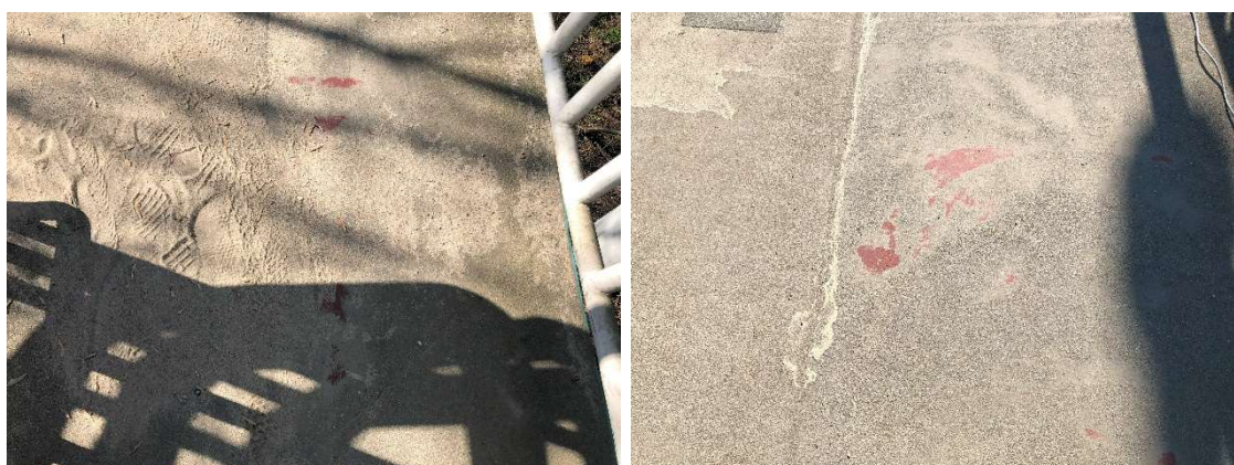
Fot. 37 Ubytki nawierzchnio-izolacji płyty pomostu
